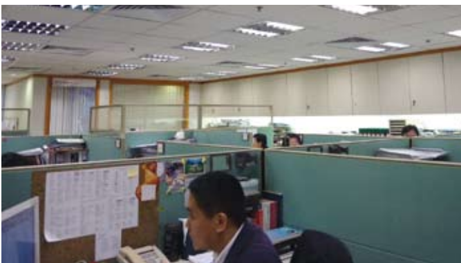
部分辦公室照明設備已作適當的拆除，以減省耗電量。
